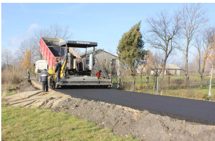
Budowa drogi poscaleniowej w Zastawiu
